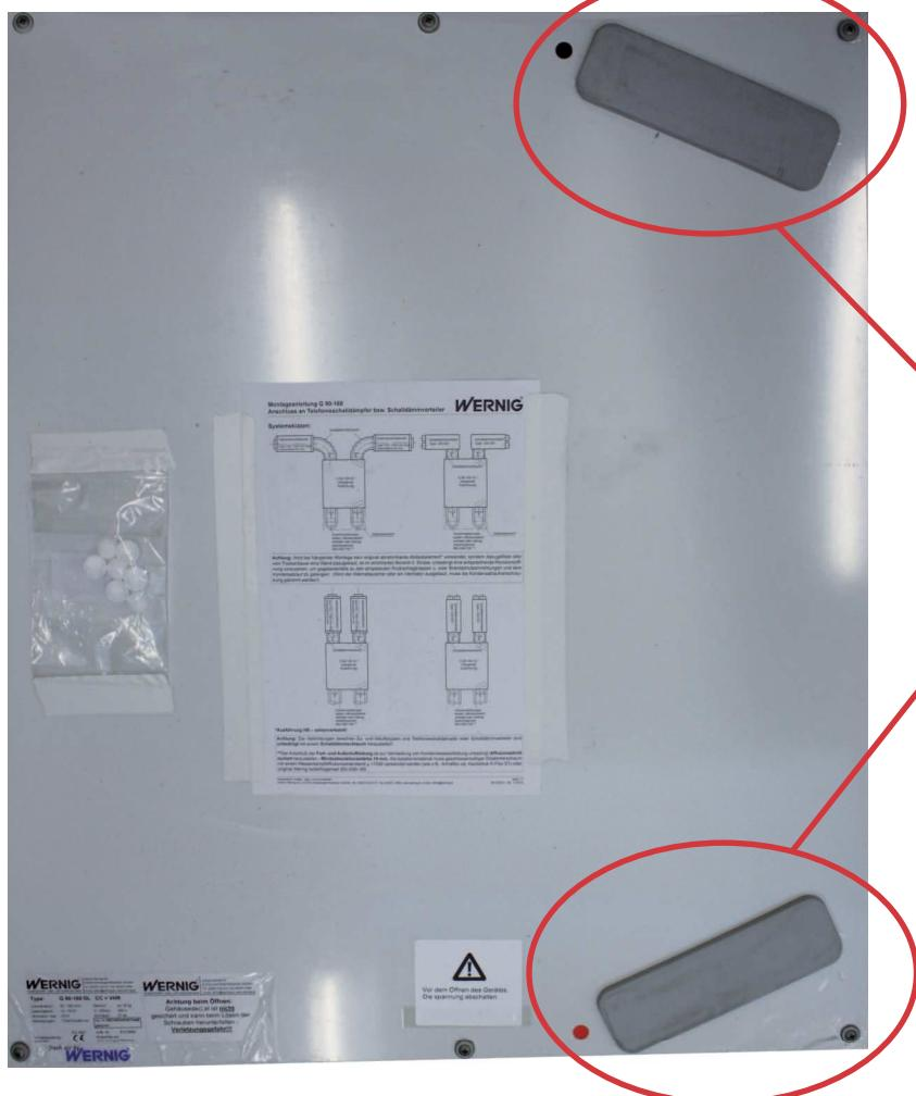
Die Filter für die Zu- und Abluft befinden sich jeweils vorne am Gerät. Bei Tausch der Filter oder Wartung öffnen Sie den Gummiverschluss und ziehen die Filter heraus.
